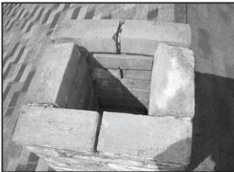
**UNLINED MASONRY CHIMNEY**
